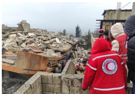
倒壊した建物で救助活動を行うスタッフ ©SARC
