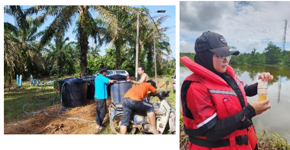
給水タンクの設置(左) 水源の水質確認(右) ©マレーシア赤新月社
