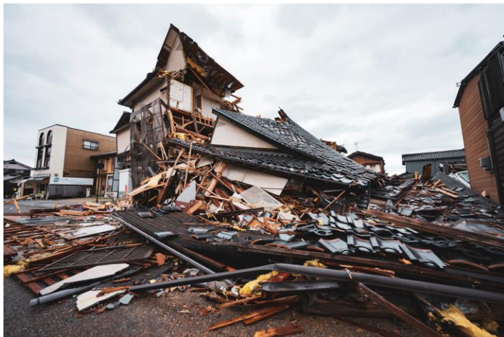
「令和6年能登半島地震により倒壊した家屋」 (石川県輪島市)
